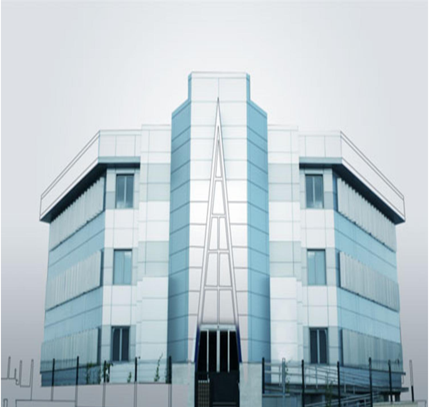
Edificio RD Sistemas
