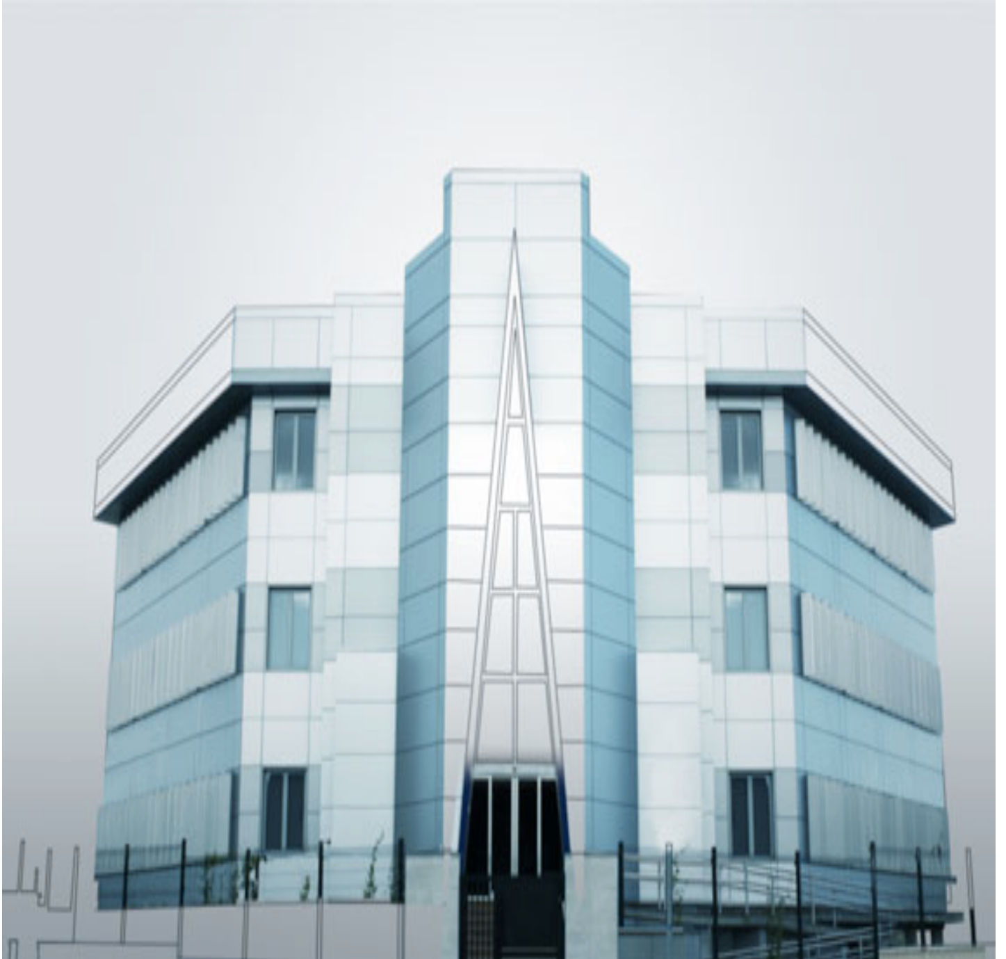
Edificio RD Sistemas
